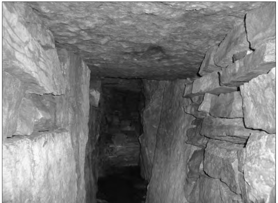
Der Gangknick (Blick vom abknickenden Gang zurück). Man erkennt deutlich die Bauart: große Steinblöcke wechseln sich mit Trockenmauerwerk ab. Obenauf ist der Gang mit großen Steinplatten abgedeckt (Foto: Stephan Baum).
