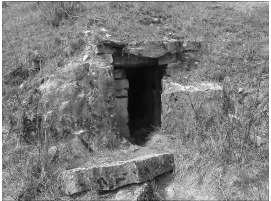
Das Eingangportal des L-Ganges (Foto: Stephan Baum)
