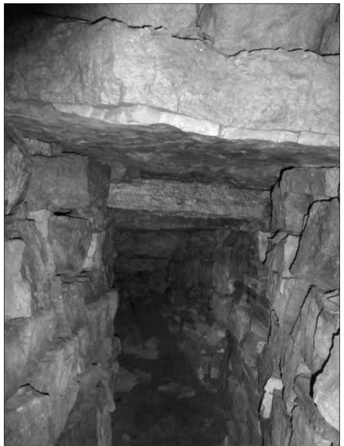
Links: Der Gangknick. Man erkennt gut das Trockenmauerwerk. Rechts: Das zusammengebrochene Ende des Querganges. An der Decke sind die Querriegel gut zu sehen. Der Gang wird hier stufenweise niedriger (Fotos: Irene Merz).
