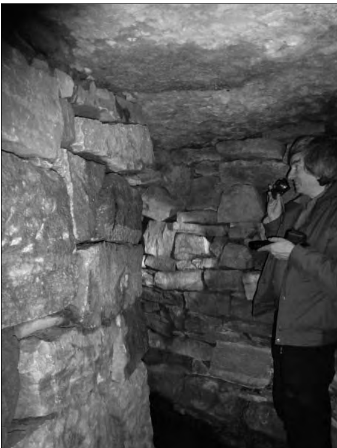
Links: Der Gangknick. Man erkennt gut das Trockenmauerwerk. Rechts: Das zusammengebrochene Ende des Querganges. An der Decke sind die Querriegel gut zu sehen. Der Gang wird hier stufenweise niedriger (Fotos: Irene Merz).
